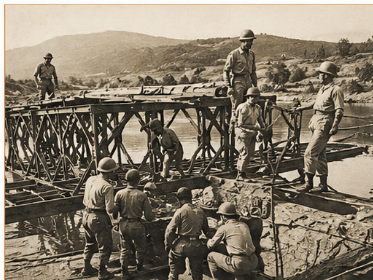
Montagem de ponte sobre o rio Serchio, obra da Engenharia brasileira na Itália.
