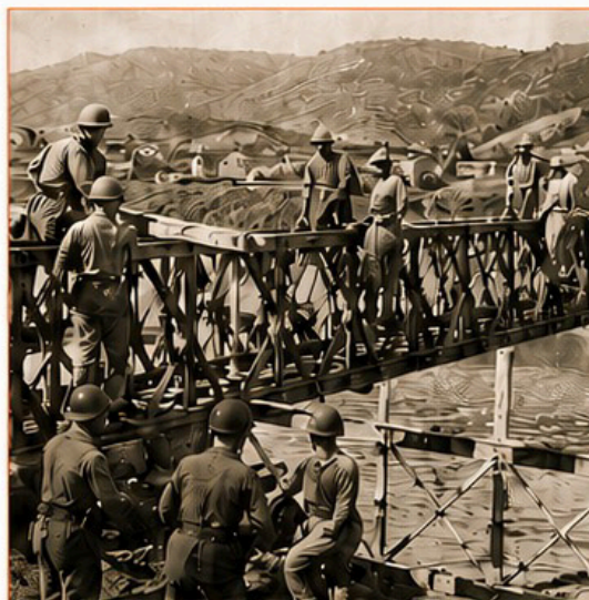
Engenheiros brasileiros trabalhando na construção de pontes durante a campanha da Itália.
