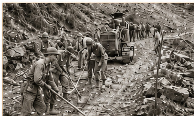
Trabalhos de abertura e manutenção de vias executados pela Engenharia brasileira durante a campanha.
